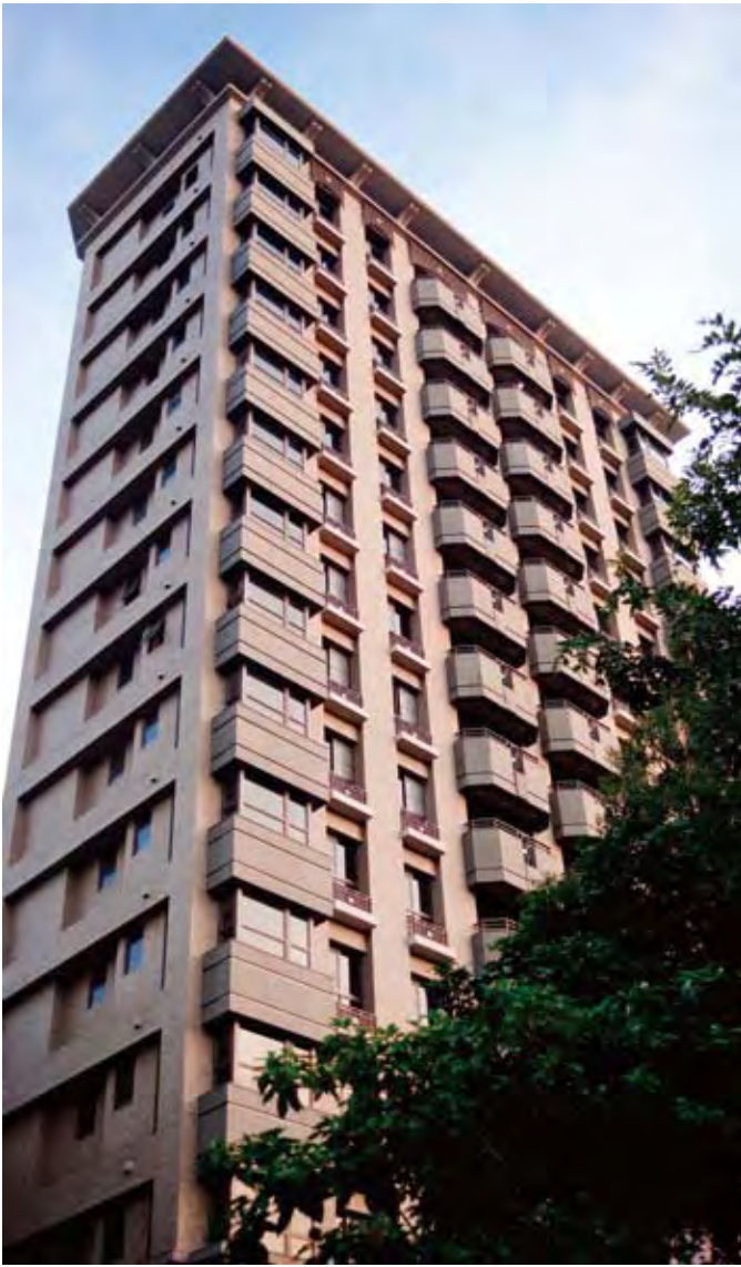
更新後現況（攝影：丁致成）
